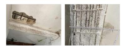
In der unteren UG-Ebene (ehem. Stallungen) sind neben der Stb.-Deckenkonstruktion auch Stb.-Unterzüge und Stb.-Stützen vorhanden. An den Regelunterzügen und Stb.-Stützen in den Zellenhöfen sind keine direkten Schadensauffälligkeiten festzustellen. Zur Sicherstellung der Dauerhaftigkeit wird auch hier eine detaillierte Schadensbegutachtung empfohlen.
