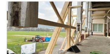
Die morschen Bereiche der Dachstützen sind abgeschnitten. Das Dach wird über die externe Konstruktion gehalten.
