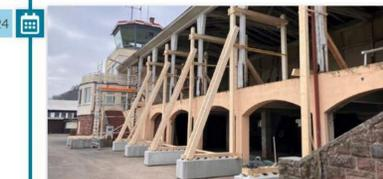
Die Stützen für das Dach stehen.
