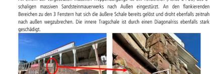
4.1a An einem der vorgesetzten massiven Treppenaufgänge ist ein Teilbereich (Achse 24-26) des 2-schaligen massiven Sandsteinmauerwerks nach Außen eingestürzt. An den flankierenden Bereichen zu den 3 Fenstern hat sich die äußere Schale bereits gelöst und droht ebenfalls zeitnah nach außen wegzubrechen. Die innere Tragschale ist durch einen Diagonalriss ebenfalls stark geschädigt.
