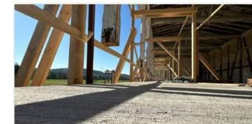
Im ersten Drittel des Turniergebäudes ist der Betonstreifen erneuert. Schalung und Bewehrung für den zweiten Abschnitt werden gebaut.
