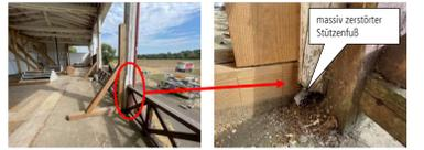
1.1a Die Stützenfüße sind seit der Erbauungszeit von 1922 unmittelbar der Witterung und Schlagregen ausgesetzt. Auf der gesamten Hallenkonstruktion sind die Fußpunkte der Holzstützen entsprechend massiv geschädigt. Ein Austausch der Holzstützen im unteren Stützmittel statisch zwingend notwendig. Vereinzelt kann auch ein vollständiger Austausch der Holzstütze notwendig werden. Die Stützen wurden über oben dargestellten Verstreibungsbocke im gesunden Holzquerschnitt gesichert.
