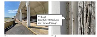
2.1a Zur Verstärkung des Mittelrisaltes wurden 1979 Stahlrahmen eingezogen. Die Stahlrahmen selbst sind in einem akzeptablen Zustand und zeigen oberflächlich stellenweise Flugrost. Die Stahlrahmen sind an den Holzstützen über Gewindestangen verbolzt und somit kraftschlüssig an die Holzkonstruktion angeschlossen.
