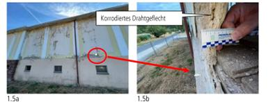
1.5a Ab der UG-Decke ist die 3-seitige geschlossene Hallenkonstruktion über eine ca. 3-5cm starke zementgebundene Wandbekleidung eingehaust. Die zementgebundene Fassade besitzt in der Mitte ein stabilisierendes Drahtgeflecht, welches an zwei Referenzöffnungen bereits vollständig korrodiert war. Das Drahtgeflecht ist unmittelbar an der tragenden Holzständerwand fixiert.
