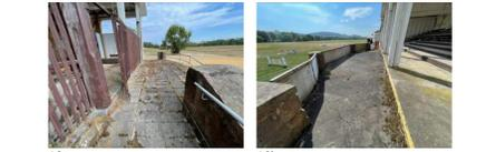
4.3a Der genaue Aufbau der vorstehenden Treppenaufgänge ist nicht bekannt. Der vorhandene Oberbelag wechselt von einer bituminösen Ausbildung im Mittelbau zu Betonplatten am rechten Aufgang. Bei der Konstruktion ist die Abdichtungsfunktion und insbesondere deren Anschluss an die Wasserführung/Rinnenabführung wieder funktionstüchtig herzustellen. Ein erneuter weiterer Wassereindring in das Außenmauerwerk gilt es zur Vermeidung von Folgeschäden zu verhindern.
