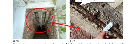
4.2a Der einzige von unten zugängliche Treppenlauf befindet sich zwischen Achse 15-17. Die drei längs verlaufenden Stb.-Unterzüge zeigen massive Korrosionsschäden an den unteren tragenden Unterzügen des Treppenlaufes. Auf den Unterzügen sind massive FF-Platten-Elemente aufgelegt. Eine zielführende Betonsanierung erscheint fraglich und ist bei einer Generalsanierung gegenüber einem Ersatzneubau in Abstimmung mit der Denkmalbehörde abzuwägen.
