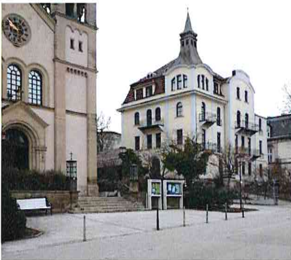
Wertvolle historische Bausubstanz
